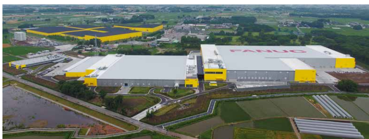
筑波2区 筑波2区
