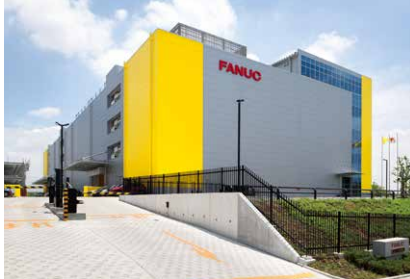
名古屋サービスセンタ Nagoya Service Center
