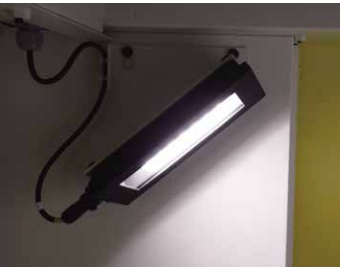
機内灯 高輝度LEDタイプを採用。取付位置は操作盤背面になります。
